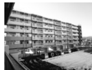
完成した災害公営住宅(気仙沼)
