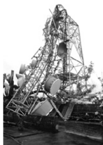
2013年12月 レイテ州ドゥラグ 台風の強風により中折れした携帯電話中継塔
